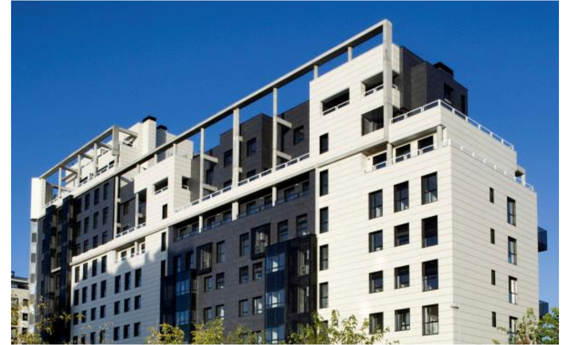
Ascensores en edificio residencial en Europa 2-7%
