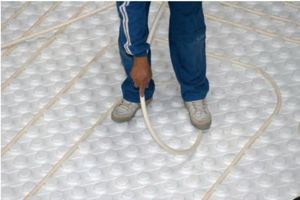
La forma de colocación del tubo se realizará de acuerdo a las especificaciones del diseño. La distribución más habitual es en espiral. Este tipo de distribución permite una distribución de temperatura de mayor homogeneidad. Una vez llevado el tramo de conexión desde el colector a la estancia el tubo de ida se llevará en primer lugar a perímetro exterior de la misma y se trazará la espiral dejando el doble de distancia entre tubos, para hacer la espiral de vuelta.
