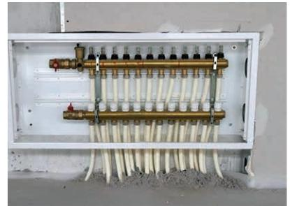
El número de vías del colector se corresponderá con el número de circuitos conectados. El número de colectores requeridos por planta dependerá del número máximo de circuitos por colector y de la distribución de la planta. El colector distribuirá agua a los circuitos conectados al mismo con la temperatura de impulsión de todos a todos ellos.
