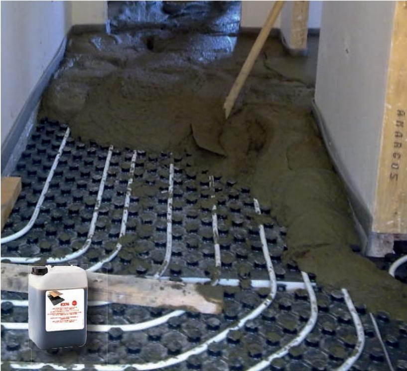
El espesor de la placa-mortero debe calcularse de acuerdo a las normas pertinentes y teniendo en cuenta la capacidad de carga y la fuerza de flexión. El grosor de mortero por encima de los tubos debe ser como mínimo de 30-40 mm sobre la generatriz superior del tubo, no aceptándose variaciones mayores a 1 cm (la base debe estar nivelada con anterioridad a la colocación del aislante).
