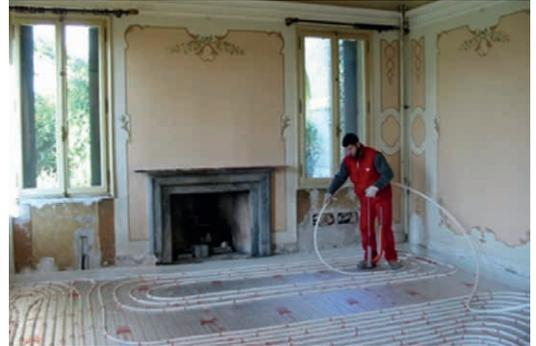
El diseño de los circuitos, longitudes etc, se detallará en la parte de cálculo. La forma típica de un circuito es la espiral donde se va mezclando tubería que lleva agua más caliente (impulsión) con agua más fría (retorno del circuito).
