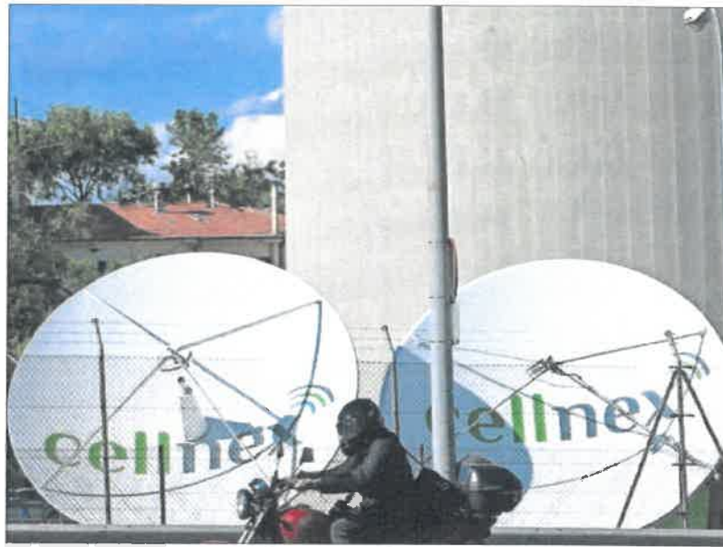
Dos antenas de Cellnex en las instalaciones de Torrespaña, en Madrid. / ULY MARTÍN
