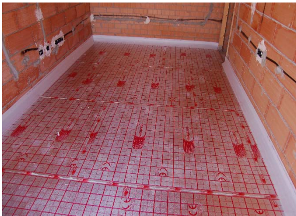
3. Solapar las planchas
