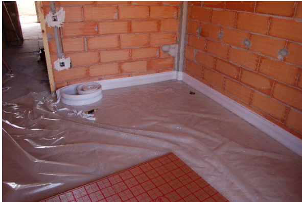
1. Film antivapor y cinta perimetral
