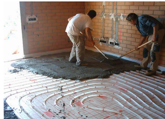
8. Extendido del mortero
