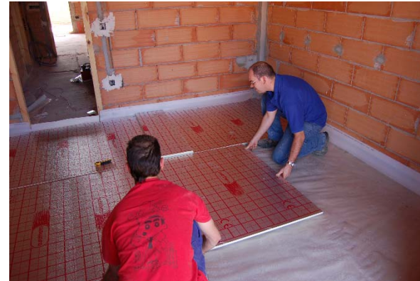
2. Colocación de la plancha
