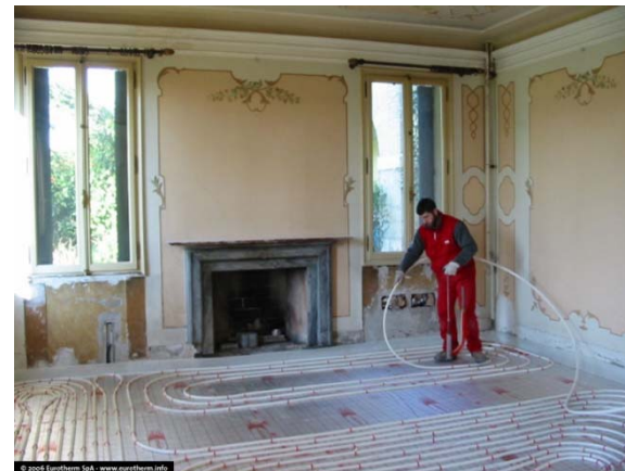
4. Instalación del tubo.
